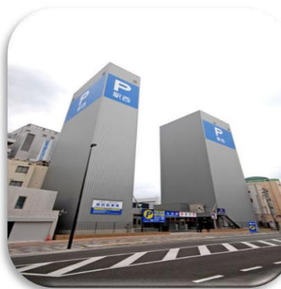
機械式駐車場（タワー式）
