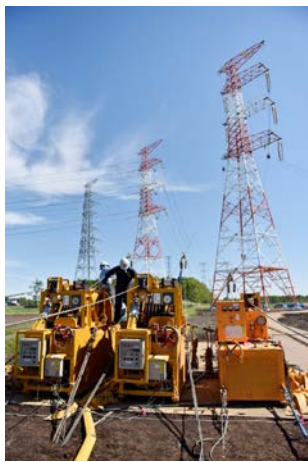
↑送電線新設工事の風景
