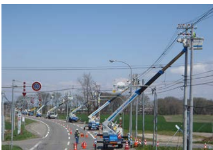
↑架空配電線工事の風景
