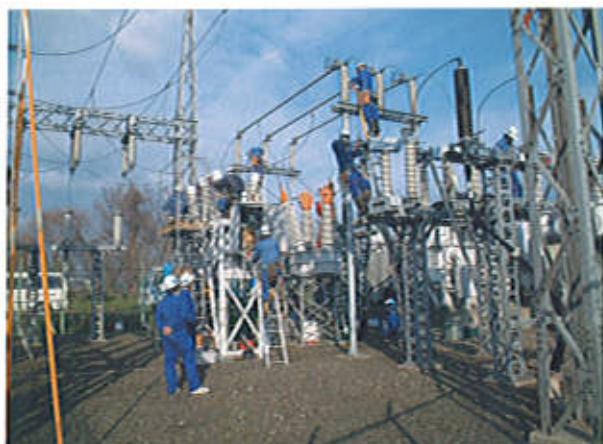
定期点検の様子
