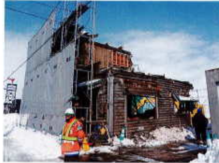
解体工事中の旧岡田邸
